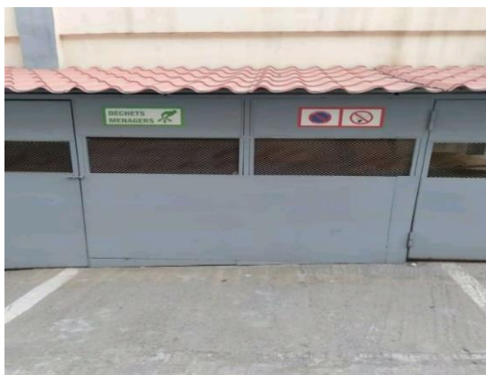
Photo 12. Lieu de stockage DAOM.
